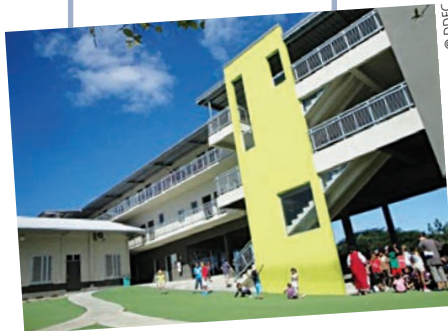
Pour faire face au doublement de ses effectifs, l'école de l'Immaculée a été rénovée et agrandie en 2011.
