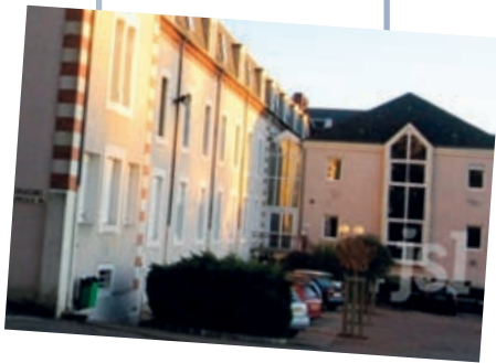
Où se loger l'été ? À l'ensemble scolaire de Paray-le-Monial !
