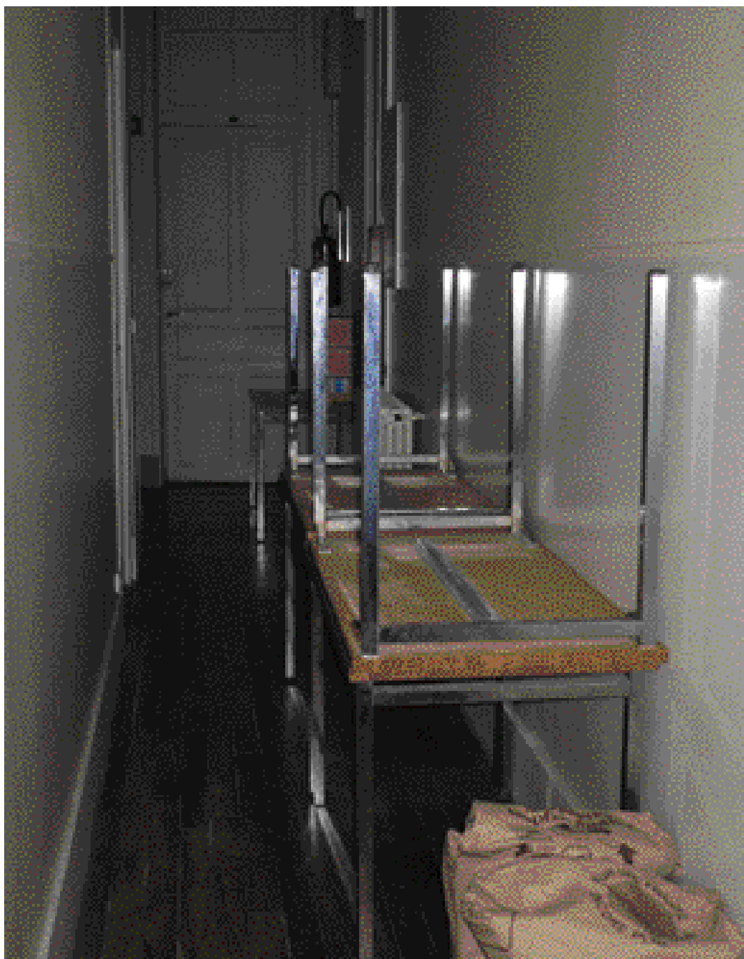
Danger. Un couloir utilisé comme lieu de stockage empêchera l'évacuation rapide d'un bâtiment. (Photo : M.-F. Comte)
