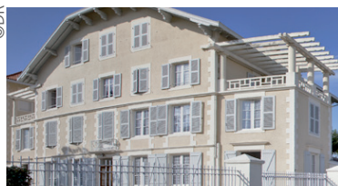
Groupe scolaire Largenté à Bayonne
